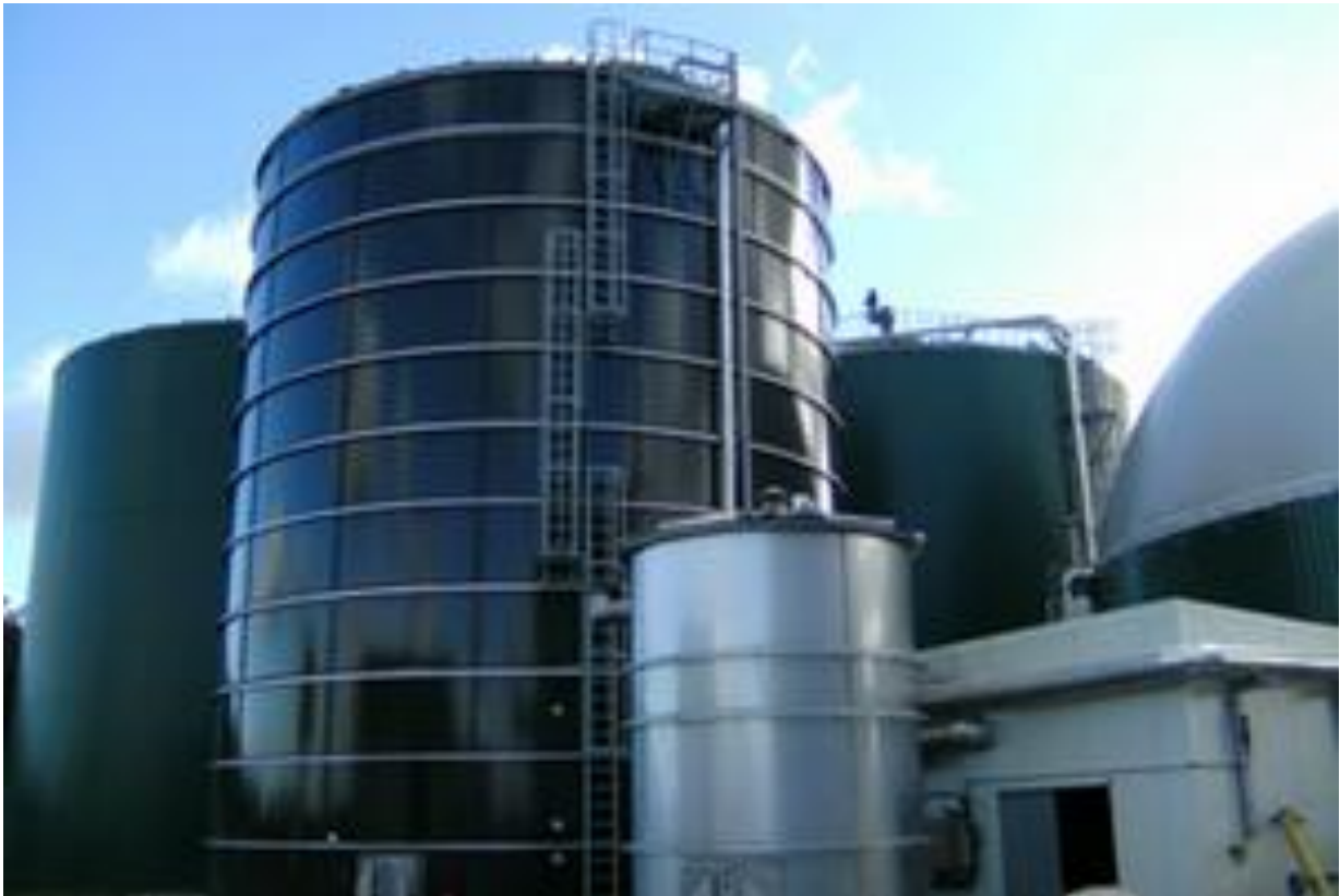
L'unité de méthanisation Géotexia à St Gilles du Mené, une des composantes du projet de territoire local (22).
